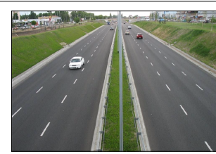
2. Modernizacja dostępu drogowego do Portu w Szczecinie
