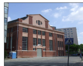
30. Trafostacja Sztuki - ochrona i odbudowa
