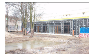
28. Rozbudowa i przebudowa budynku Żłobka Miejskiego nr 8
