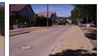
13. Osiedle Kijewo przebudowa ulic Rysiej i Kaczej
