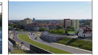
7. Trasa Północna Etap Ia -Przebudowa ul. Warciśława od Przyjaciół Żołnierza do ul. Bocianiej
