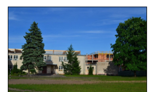
31. Rozbudowa budynku SP 59 o segment dydaktyczny
