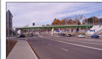
8. Obwodnica Śródmieścia Etap V - budowa ulicy od ul. Duńskiej-Krajskiego do ul. Arkońskiej
