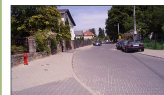
14. Osiedle Warszawa - Budowa ulicy Jemiołowej z infrastrukturą techniczną na osiedlu Warszawa
