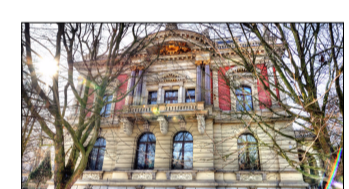
34. Willa Lentza Etap II Modernizacja obiektu
